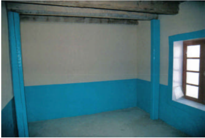
foto 8 - pali di sostegno negli alloggi insegnanti
