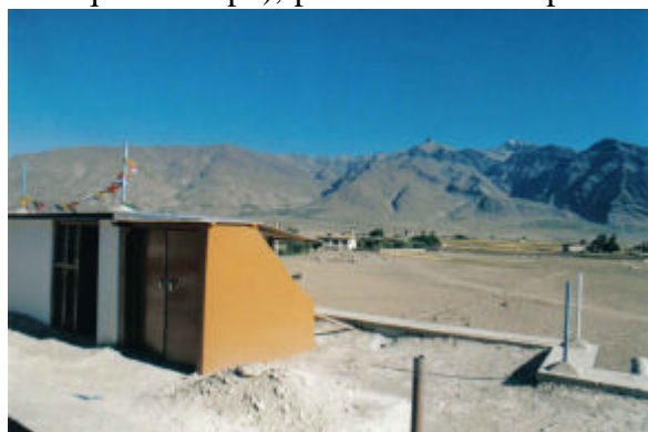
Foto 11 - la cabina dei generatori sul tetto della scuola
