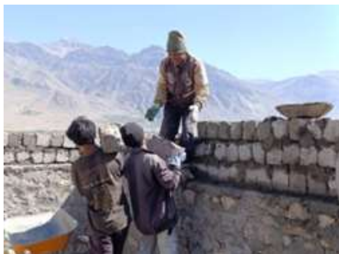
Fig.27 costruzione del muro di recinzione
