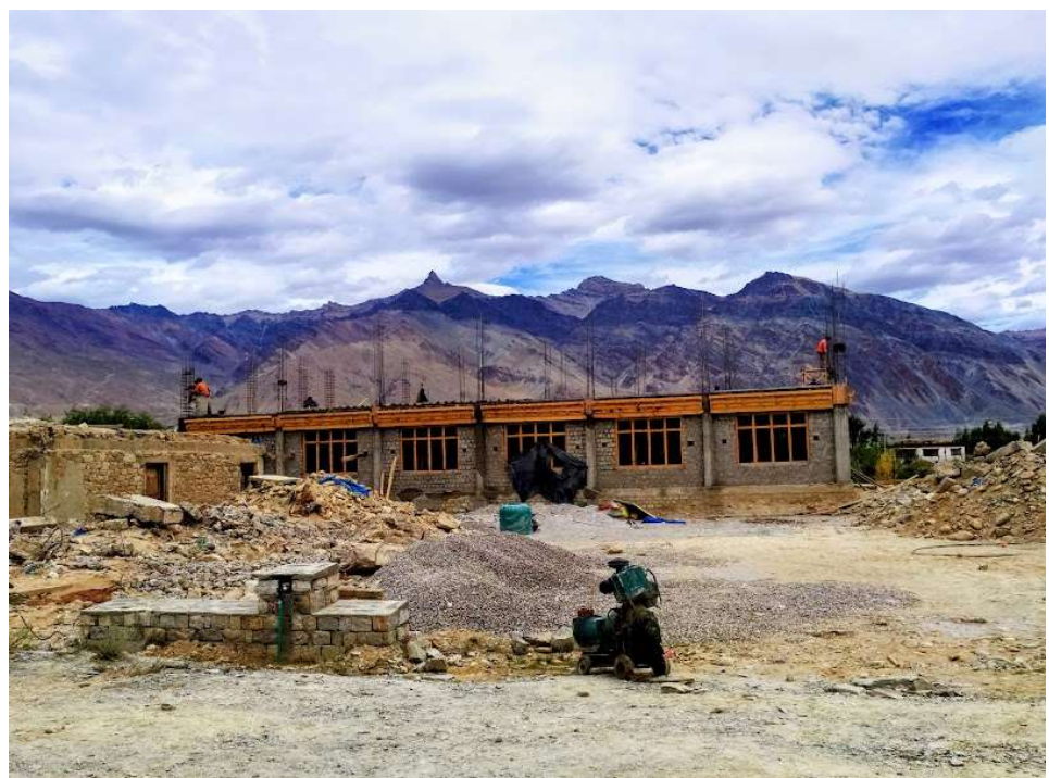
fig.15 il Multipurpose hall in costruzione
